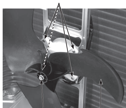
Propeller fan nut
