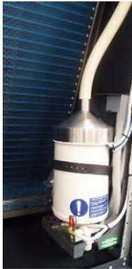
Złącze ssania wody nawilżacza jest 3/4" G M – ISO 228/1, a złącze odprowadzania wody jest gładki przewód o 32 mm M.
