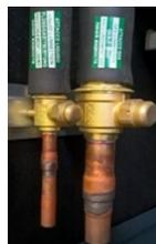
3. Откройте краны машины и выполните вакуумирование с помощью рабочих разъемов (Ø 5—16").
