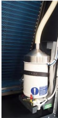
Le raccord d'aspiration d'eau de l'humidificateur est 3/4" G M - ISO 228/1 et le raccord d'évacuation de l'eau est un tuyau lisse de 32 mm M.
