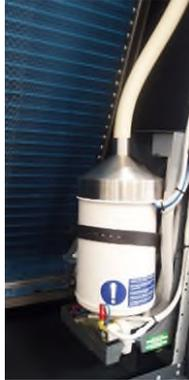
Η σύνδεση εισαγωγής νερού του υγραντήρα είναι 3/4 "G M - ISO 228/1 και η σύνδεση εκροής νερού είναι ένας λείος σωλήνας 32 mm M.
