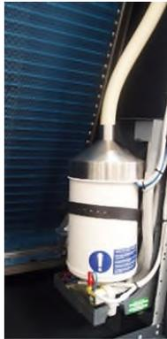
L'attacco di aspirazione dell'acqua dell'umidificatore è 3/4" G M – ISO 228/1 e l'attacco di scarico dell'acqua è un tubo liscio da 32 mm M.
