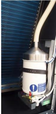
Vandets sugemunding i befugteren er 3/4" G M – ISO 228/1 og vandets afløbsmunding er et glat rør på 32 mm M.
