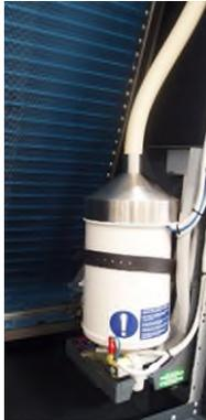
De waterinlaataansluiting van de bevochtiger is 3/4" G M – ISO 228/1 en de wateruitlaataansluiting is een gladde pijp van 32 mm M.
