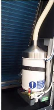
La conexión de entrada de agua del humidificador es de 3/4" G M - ISO 228/1 y la conexión de salida de agua es una tubería lisa de 32 mm M.
