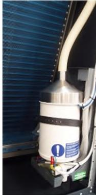
Der Wasserausgangschluss des Befeuchters ist 3/4" G M – ISO 228/1 und der Wasserauslass ist ein glattes Rohr mit 32 mm M.
