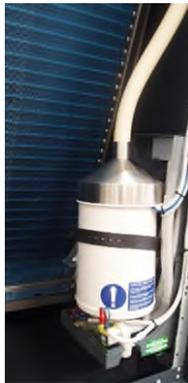
Соединение для откачивания воды увлажнителя — 3/4" G-M — ISO 228/1, а соединение для слива воды представляет собой ровную трубу диаметром 32 мм М.
