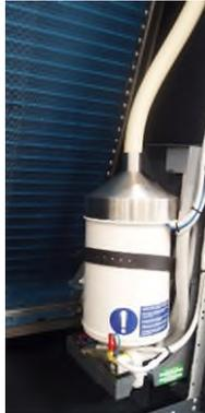
Fukterens vanninntakskobling er 3/4" G M – ISO 228/1 og vantømmingskoblingen er 32 mm M glatt rør.
